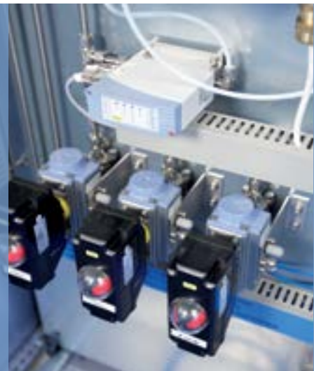
Pneumatisch aangedreven isolatieventielen Type 8805 worden gebruikt in het hele systeem.
